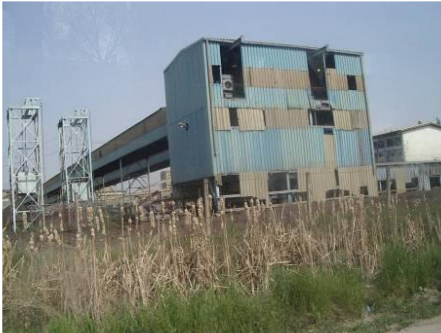
La ultra inquinante centrale elettrica nei pressi di Obelice, butta fuori fumi giorno e notte, senza contare l'inquinamento del terreno circostante cosparso degli scarti di lavorazione.
